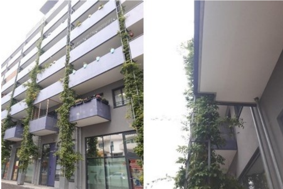
Abbildung 19: Beispiel für wärmebrückenfrei montierte Rankhilfen außerhalb der Gebäudehülle (Bildquelle: TU Wien, 2019)
