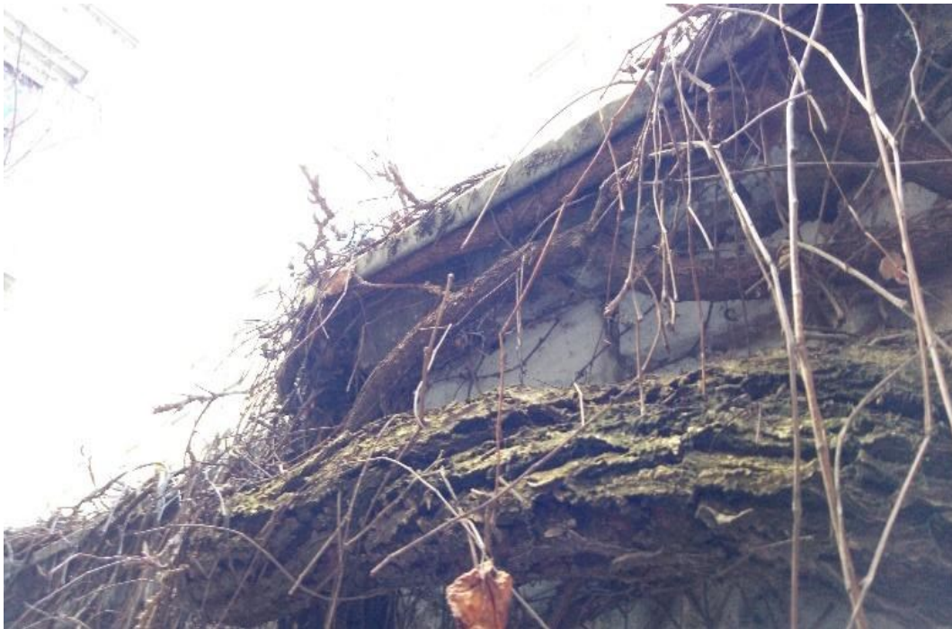
Abbildung 28: Beispiel für bautechnisch kritisch gewachsene Kletterpflanzen unter der Verblechung (Bildquelle: TU Wien, 2019)
