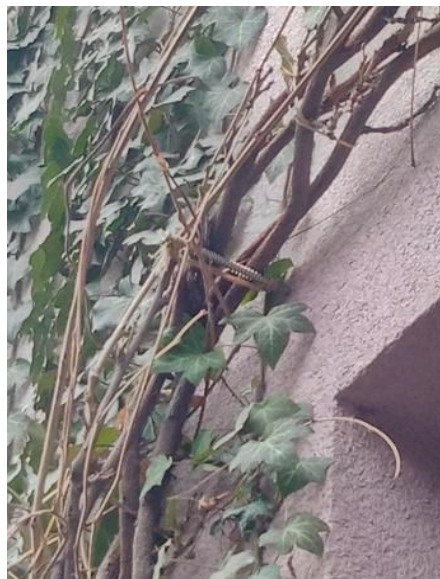
Abbildung 27: Beispiele für aus bautechnischer Sicht ungeeignete Rankhilfen und Befestigungen (Bildquelle: TU Wien, 2019)
