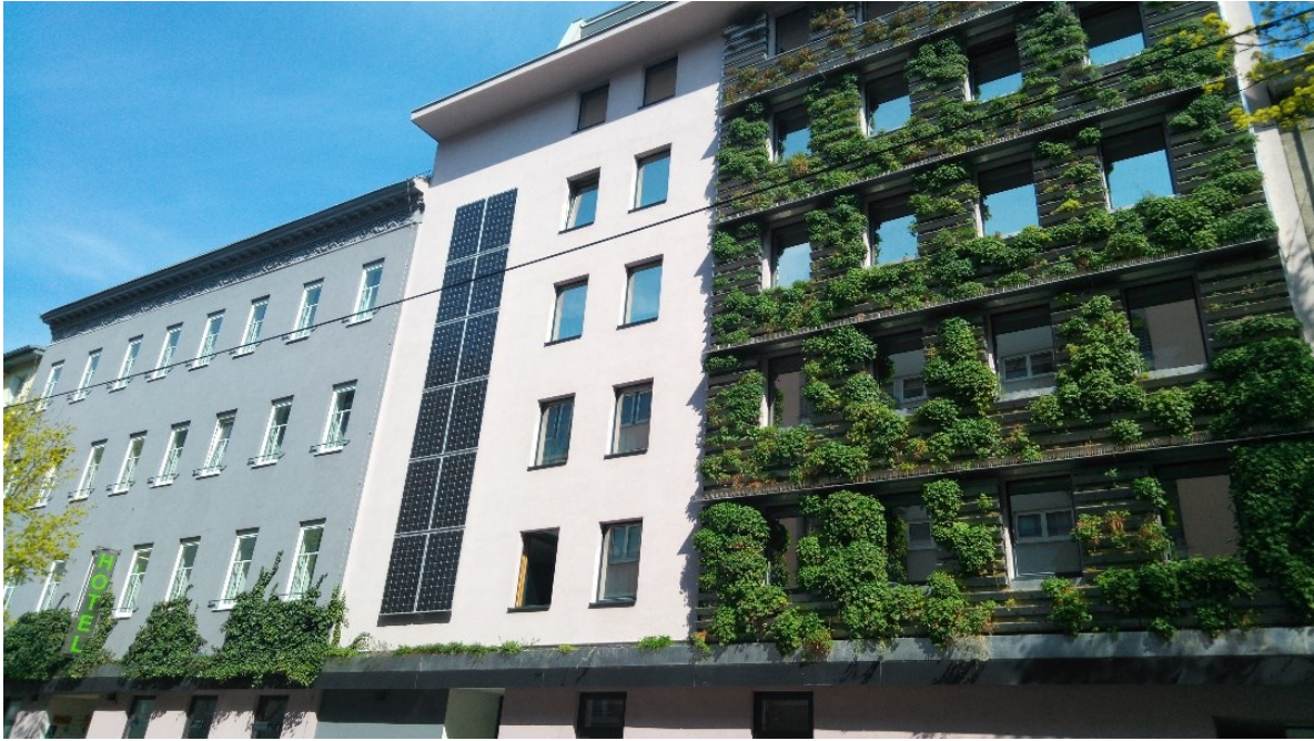
Abbildung 20: Beispiel für geschossweise integrierte horizontale Brandriegel aus Metall (Bildquelle: Dipl.-Ing. Ralf Dopheide e.U., 2020)
